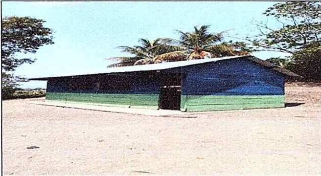
FOTO 1: Se observa la necesidad de la infraestructura.
